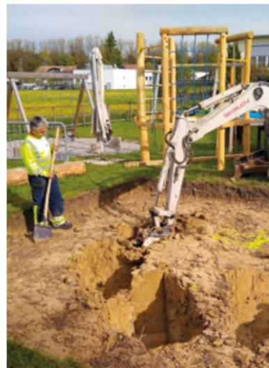
Die Baustelle wird vor Beginn geschützt und abgesperrt. Das Klettergerüst muss gegen das Umfallen gesichert und die Befestigung ausreichend verankert werden. Gerundete Kanten und Ecken sowie ein
