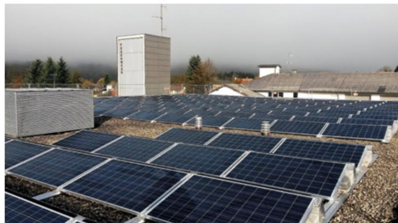
2015 wurde am Dach des Hörbranzner Feuerwehrhauses eine PV-Anlage errichtet. Die installierte Leistung beträgt 52,26 kWp (Kilowatt-Peak) bei einer Modulanzahl von 201 Stück. Übrigens, damals haben sich viele Haushalte mit dem Kauf einer Sonnenstrom-Aktie daran beteiligt.
