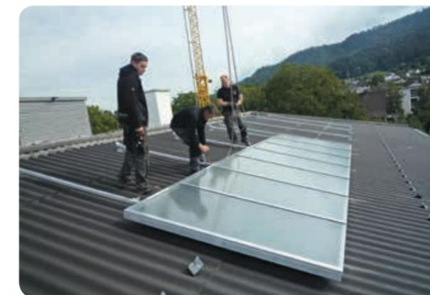
Anbringung der 58,4 m<sup>2</sup> Solarfläche
