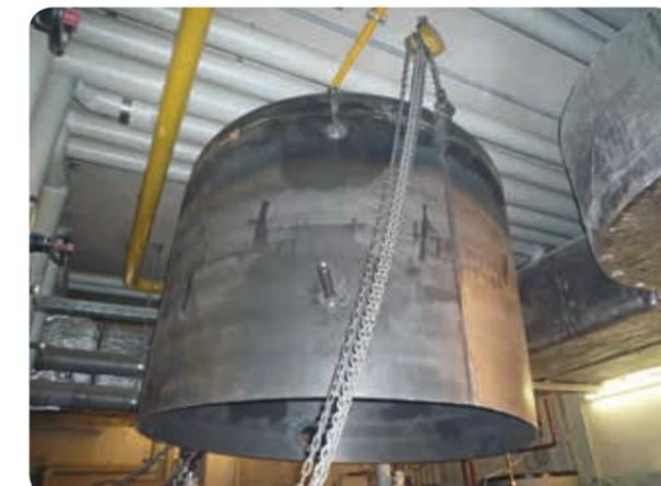
Montage des Pufferspeichers mit einem Wasservolumen von 6000 l
