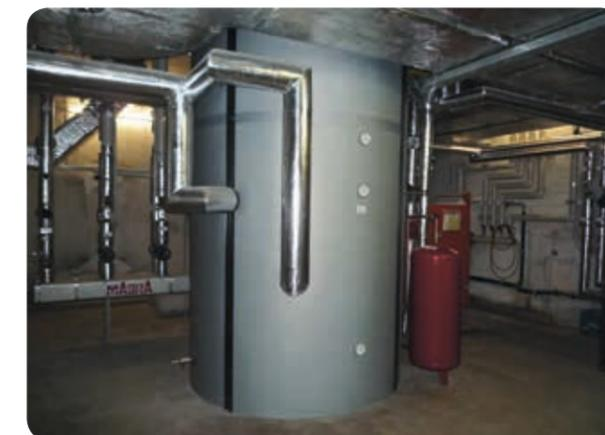
Der Pufferspeicher fertig isoliert und installiert
