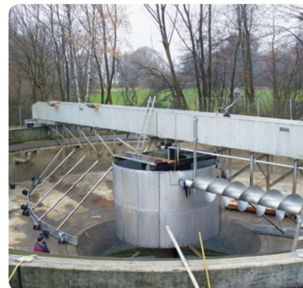
In den Nachklärbecken setzt sich der Belebtschlamm, der aus dem Belebungsbecken zufließt ab und wird wieder zurück ins Belebungsbecken gepumpt. Das zu ca. 97% geklärte Abwasser fließt über die Ablaufrinne in den Bodensee ab.
