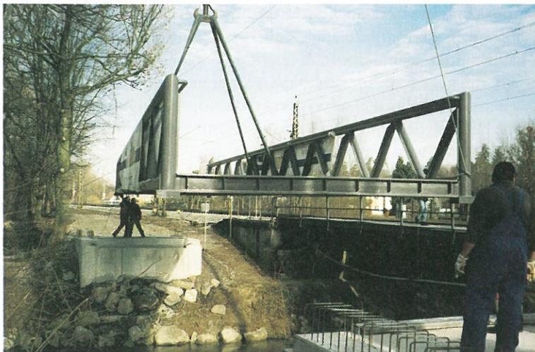
Der Mobilkran hebt die Stahlbrücke auf die Fundamente.
