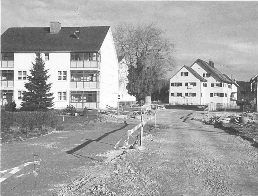
Die Arbeiten für den Ausbau dieser Landesstraße mit gleichzeitigem Gehsteigausbau geht zügig voran. Auch hier wird die Straßenbeleuchtung mitverlegt. Die Stadtwerke Bregenz verlegt die Gasleitung und die Post hat ebenfalls umfangreiche Leitungseinbauten vorzunehmen. Gelegentliche Behinderungen bzw. Straßensperren sind leider nicht zu vermeiden. Wir danken für Ihr Verständnis.
