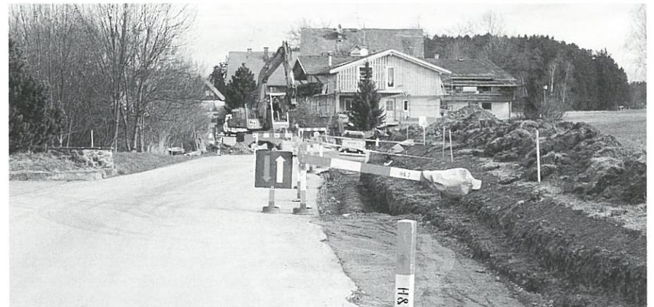
Die Firma Hilti und Jehle, Feldkirch, hat mit der Errichtung eines Gehsteiges an der Heribrandstraße begonnen. Gleichzeitig muß auch eine Straßenentwässerung erstellt werden. Die Straßenbeleuchtung wird ebenfalls mitinstalliert. Im Unterbau des Gehsteiges wird auch die Gasleitung mitverlegt.
