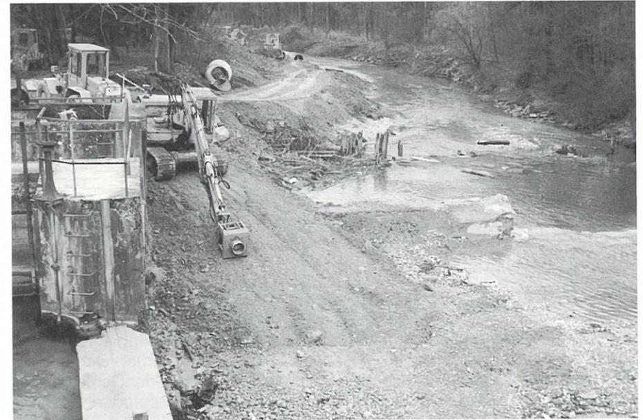
Die zum Teil baufällige Wehranlage in der Leiblach soll teilweise abgetragen und durch zwei Sohlrampen ersetzt werden. Durch den Wegfall der beiden insgesamt 5,5 m hohen Abstürze (Wasserfall) und die Errichtung der Rampen ist ein Aufziehen der Fische, insbesondere der Seeforelle, möglich.
