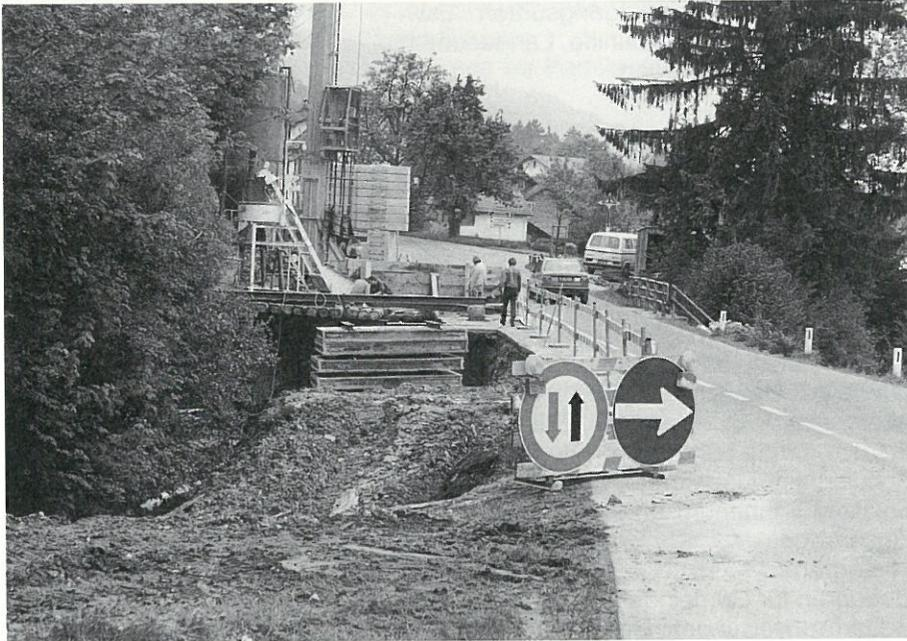
Die Sanierung der Bergerbachbrücke mit gleichzeitiger Verbreiterung (beidseitiger Gehsteig) geht zügig voran. Die Flügelmauern parallel zur Straße sind sehr hoch und müssen unter die Bachsohle fundiert sein. Die Erstellung der Gehsteige bedeutet dann keinen besonderen Aufwand mehr. Mit dieser Maßnahme ist dann ein weiterer Gefahrenpunkt in der Gemeinde behoben. Ich darf mich bei allen, die für diese Maßnahme Grund abgetreten haben, recht herzlich bedanken.
