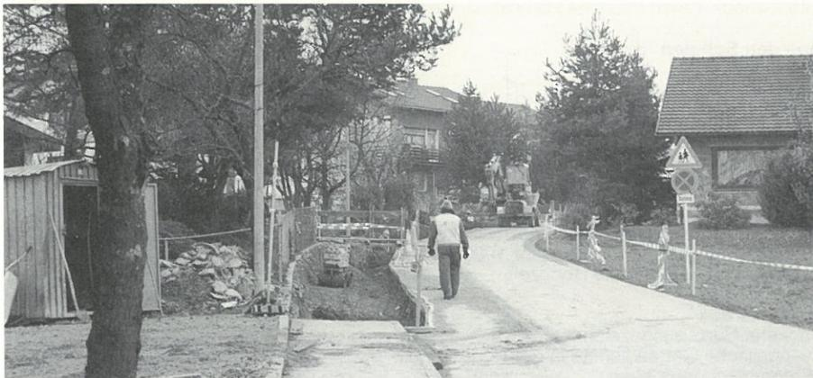
Der Ausbau des Gehsteiges in der Römerstraße ist sehr aufwendig, da gleichzeitig die Leitungsverlegung für Gas, Wasser, Telefon und Beleuchtung erfolgt.
