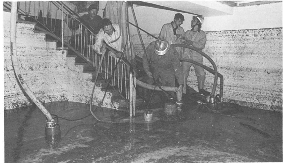
Das Kellergeschoß in der Volksschule wird ausgepumpt. Der ursprüngliche Wasserstand ist an der Wand ersichtlich.
