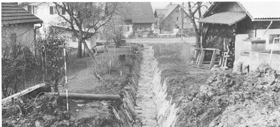
Die Ausbauarbeiten des Ziegelgrabens gehen bereits im oberen Bereich der Vollendung entgegen. Die Ausführung erfolgt in einer möglichst naturgerechten Ausbauphase. Die Bäume und Sträucher, die zwingend durch die Arbeiten entfernt werden mußten, werden in großzügiger Weise wieder nachgepflanzt.
