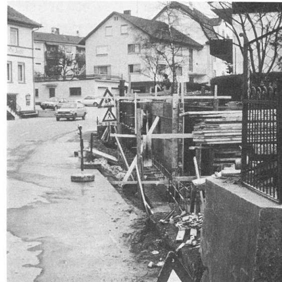
Bei den Gehsteigarbeiten an der Einmündung der Ziegelbachstraße in die Lindauer Straße wurde nun die Stützmauer zurückversetzt, so daß in Kürze auch die restlichen Gehsteigarbeiten ausgeführt werden können. Mit diesem Gehsteig ist ein wertvoller Beitrag für die Sicherheit der Fußgänger im Ortszentrum geleistet worden.
