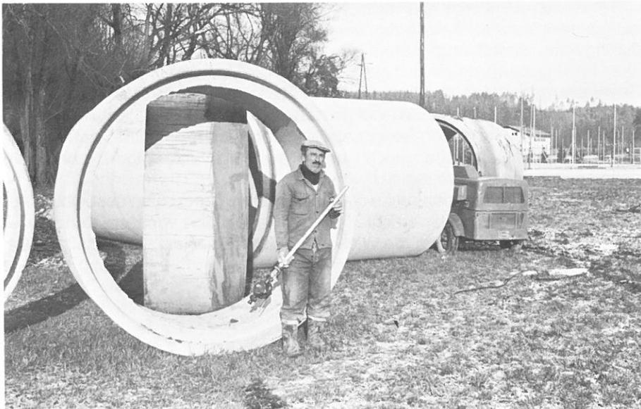
Hier werden riesige Rohre mit einem Durchmesser von 2 m verlegt.
