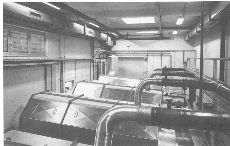
Die Siebanlage, in der die mechanische Reinigung erfolgt.
