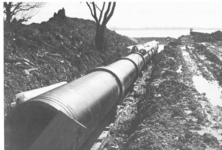
So wurde die Seeleitung am Ufer zusammengebaut und dann in den See hineingeschoben und versenkt.
