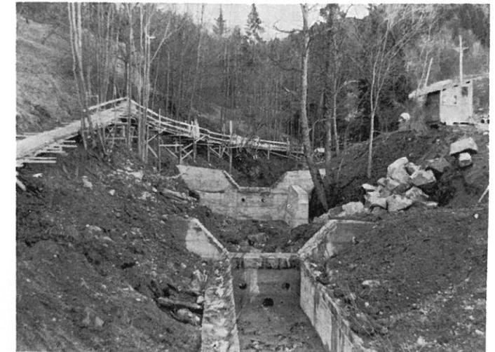
In den Wintermonaten wurde der Ausbau des Eplisgehrbaches durch die Wildbachverbauung weiter vorangetrieben. Über den Eplisgehrbach wurde eine Notbrücke erstellt. Das Bild zeigt die Baustelle östlich dieser Brücke bergwärts.
