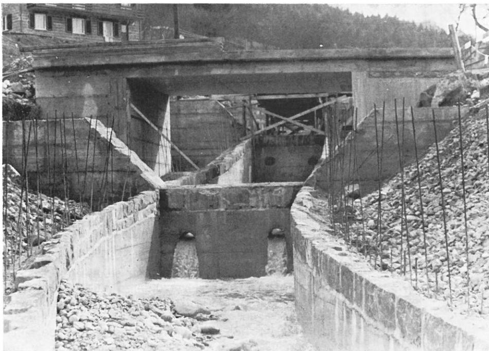
Geschiebesperren im unteren Verlauf des Eplisgehrbaches
