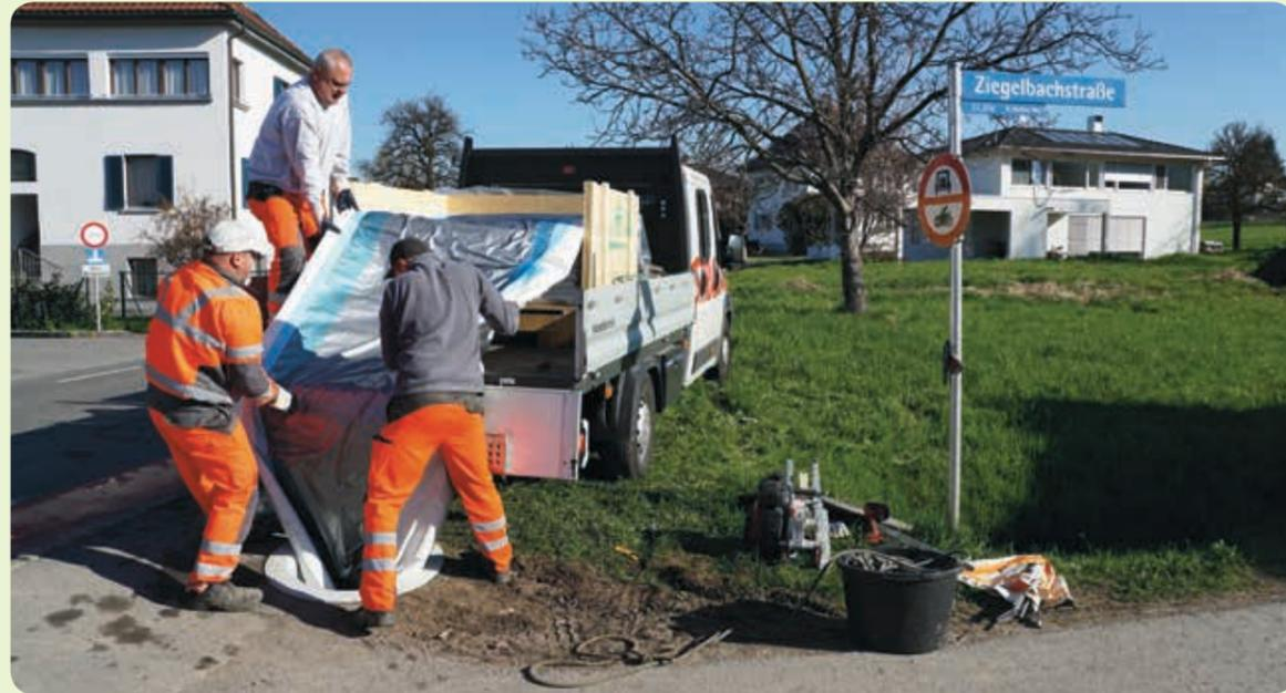
Der Kunststoffschlauch ist mit flüssigem Kunstharz gefüllt und wird über den Kontrollschacht in das Kanalrohr bis zum nächsten Kontrollschacht eingezogen. Anschließend wird der Kunststoffschlauch aufgeblasen. Zur Aushärtung der ca. 10 mm dicken Schlauchwand werden Leuchtkörper durchgezogen, die mit ultraviolettem Licht den flüssigen Kunststoff erhärten.
