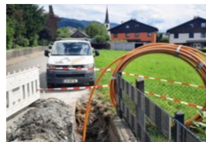
Glasfaser: Bauarbeiten im Sommer 2024
