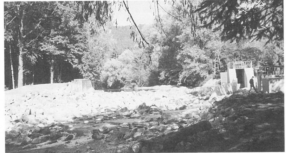
Diese Baumaßnahmen sind praktisch abgeschlossen. Anstelle der Abstürze wurden zwei Blocksteinrampen erstellt (Bild). Zusätzlich wurde für den Aufstieg der Fische (vor allem für die Seeforelle) eine Fischleiter erstellt. Die Ableitung des Mühlbaches wurde ebenfalls neu instandgesetzt.
